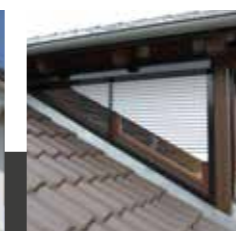
Cassonetto orizzontale in alto sopra la finestra, telo che chiude verso il basso, è l'avvolgibile di tipo SU
